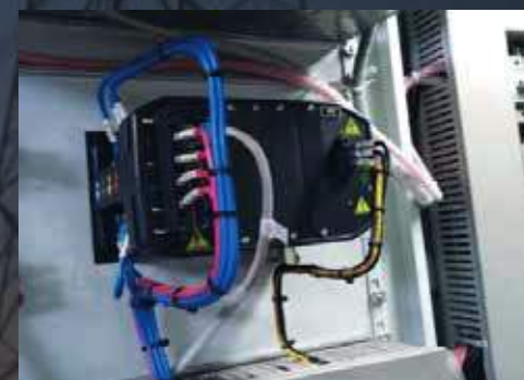
Conexión de cables terminados
