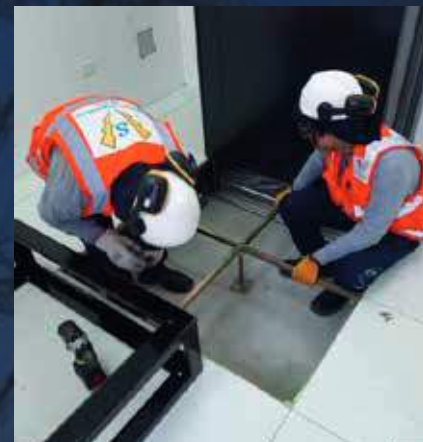
Instalación de bases para tableros
