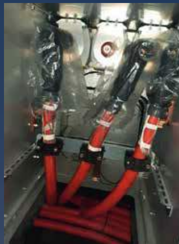
Terminaciones correctamente instaladas Tendido de cables de media tensión
