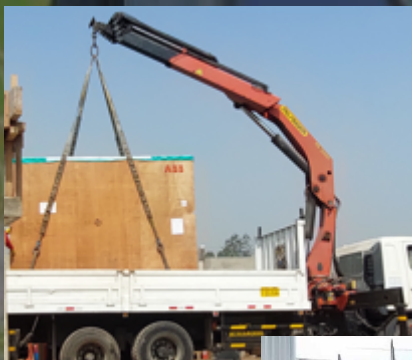
Traslado a la subestación de celdas GIS 60 KV
