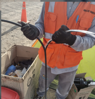
Retirado de cubierta de cable de FO
