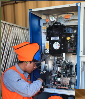
Mantenimiento de interruptores y seccionadores
