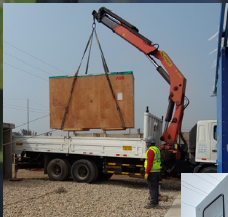
Traslado a la subestación de celdas GIS 60 KV
