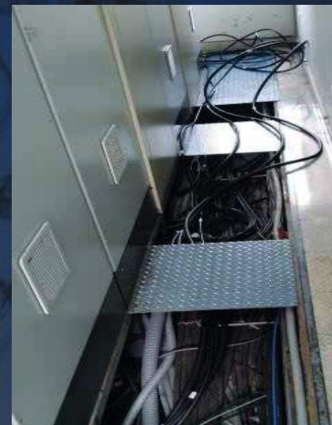
Tendido de cables para las señales
