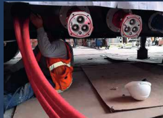
Terminaciones correctamente instaladas Tendido de cables de media tensión
