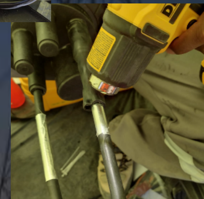
Sellado de ingreso de cables
