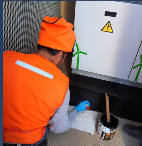
Pintado de superficies oxidadas
