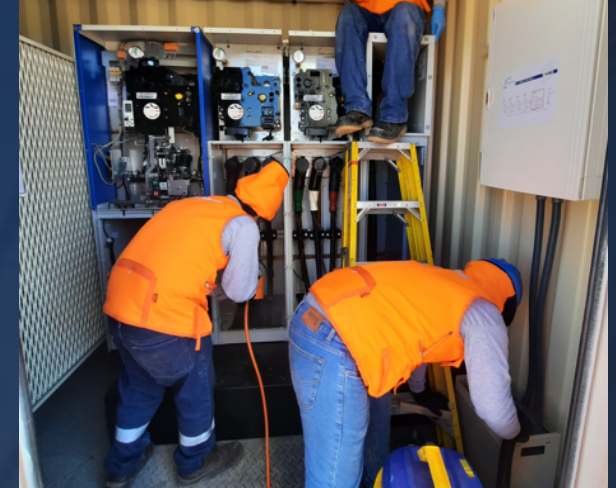
Pulverizado y limpieza de acometida de cables de MT
