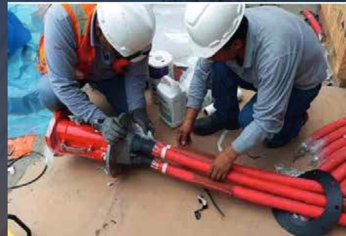
Preparación de terminaciones
