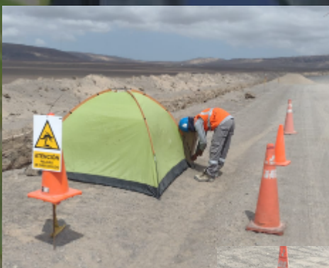
Acondicionamiento de area de trabajo
