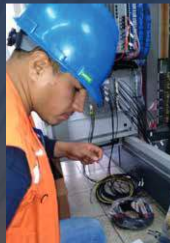
Conexionado del registrador
