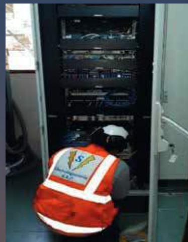
Preparación de terminaciones
