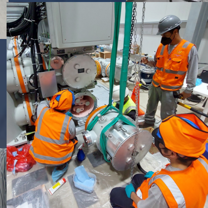
Montaje de compartimientos
