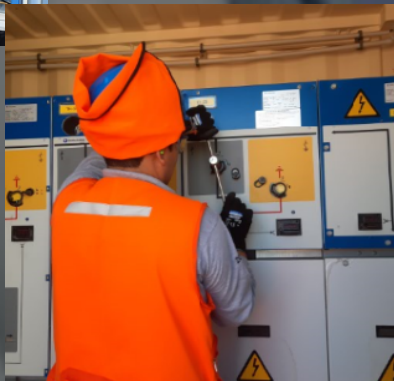
Pruebas de operación manual
