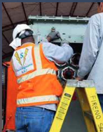
Conexionado y torqueado
