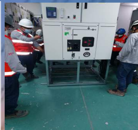
Traslado de celda de llegada
